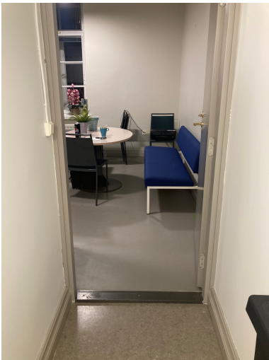
12) Huoneen D108 ovi: oviaukko 79 cm, kynnys 2,5 cm
