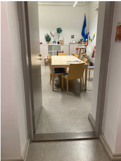
10) Välikäytävän ovi: oviaukko 76 cm; hyllyjen väli 76 cm; kynnys 2,5 cm
