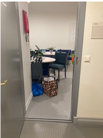
12) Huoneen D108 ovi: oviaukko 79 cm, kynnys 2,5 cm
